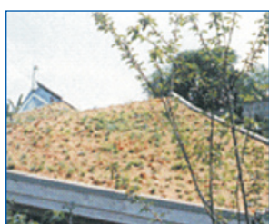
Контролирующие эрозию маты Secumat®, при устройстве сада на кровле
