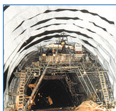
Применение SECUTEX® при строительстве тоннелей в качестве защитного слоя
