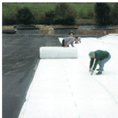
Монтаж Secudraen® вна полигоне по захоронению отходов (г. Вольфсбург, Германия)
