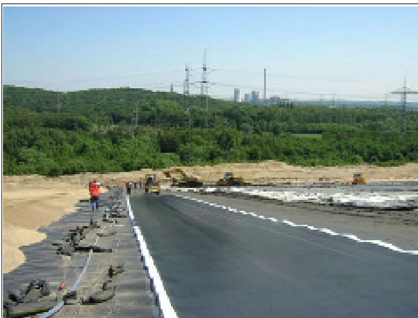
Рис. 15: Укладка геомембраны
