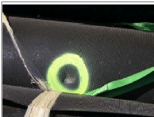
Рис.13 Пример возможного повреждения
