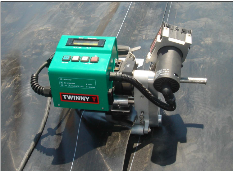
Рис.19 Сварка геомембраны
