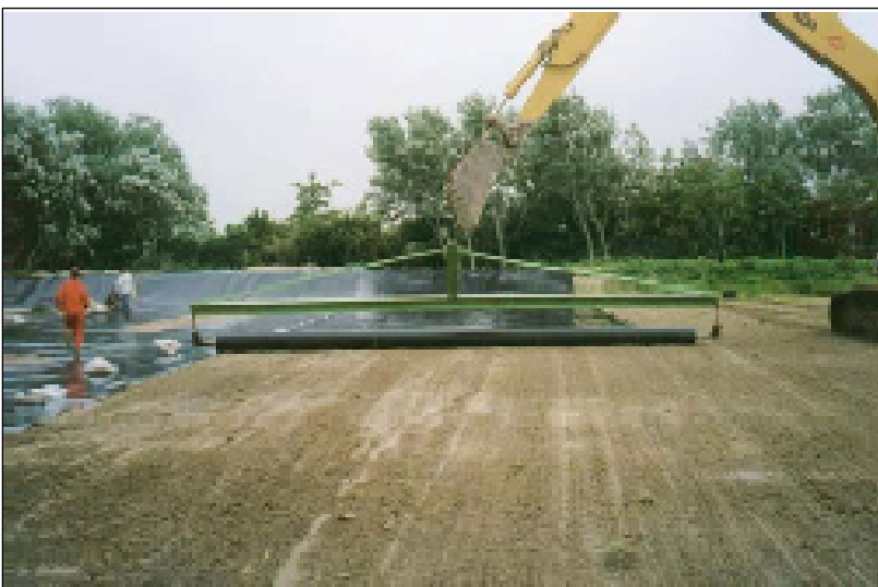
Рис. 17 Укладка геомембраны шириной 9,40 м
