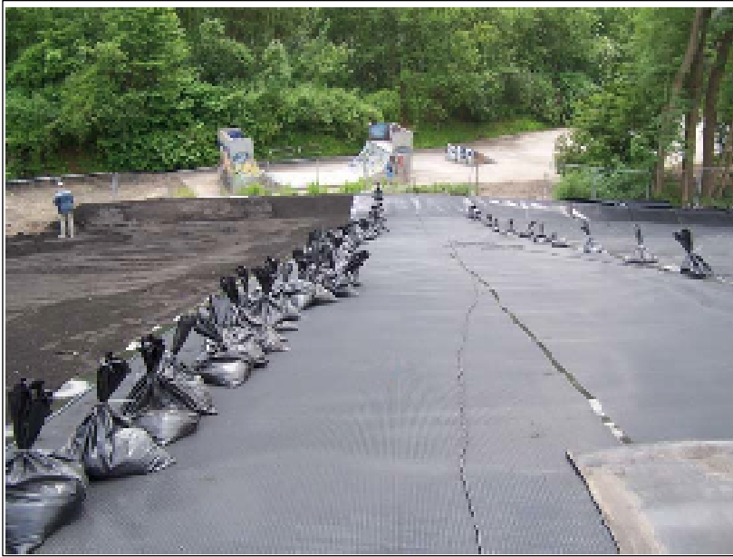
Рис.16 Использование балласта для удержания геомембраны на месте
